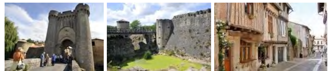
Figure 354 : Parthenay. Le circuit du quartier St-Jacques permet de découvrir la porte St-Jacques, les ruines du château et la rue de Vau avec les maisons à pans de bois (Source : https://www.tourisme-deux-sevres.com )
