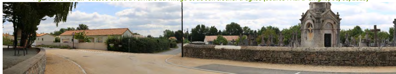
Figure 319 : Les ZIP se placent à l'arrière de la trame bâtie (Source : AEPE-Gingko, 06/08/2019)
