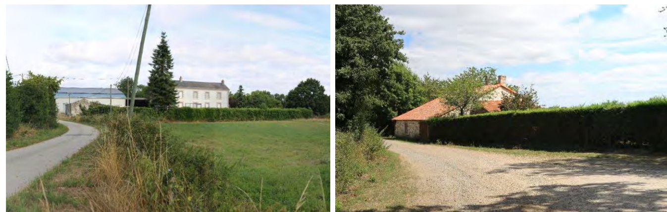
Figure 338 : De nombreux corps de ferme, et bâtiments agricoles associés, parsèment le territoire - ici, les Versennes, la Poterie et le Gas (Source : AEPE-Gingko, 06/08/2019)
